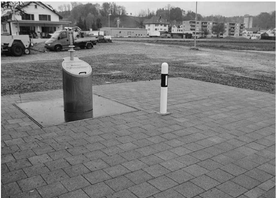
Unterflurcontainer Bleikenrütistrasse, Kradolf
