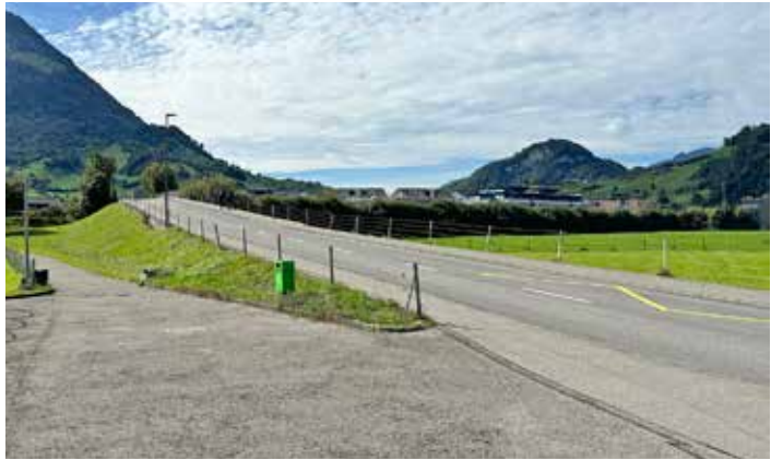
Die Überführung Eichli entspricht nicht mehr den Anforderungen.
