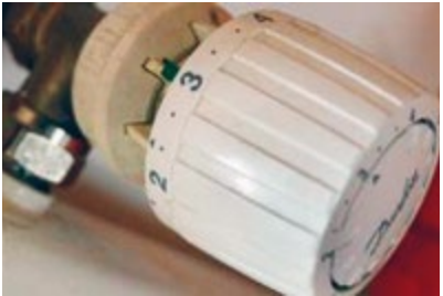
Mit Thermostatventilen lassen sich die Temperaturen in den einzelnen Räumen regeln.
