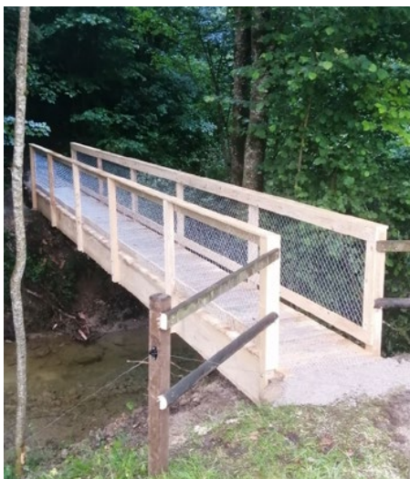
Die neue Fussgängerbrücke Hertenbergtobel
