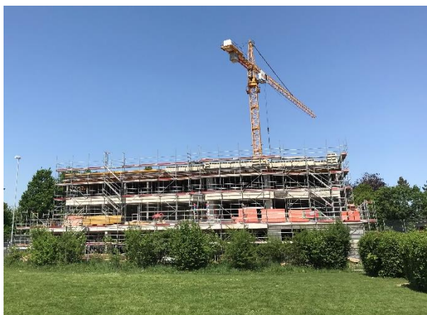
Das Quartierschulhaus BZZ hat an der Aufrichte im Mai 2018 mit seinen drei Geschossen die maximale Höhe erreicht
