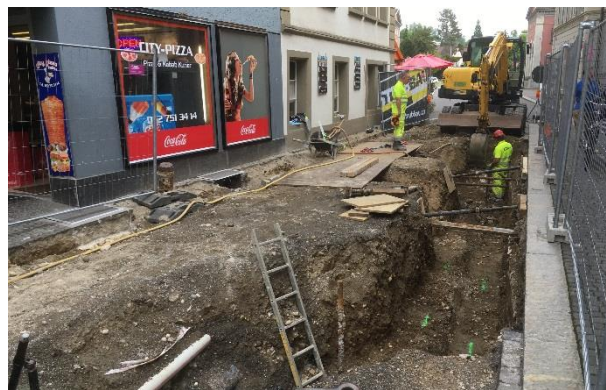
Sanierung der Werkleitungen in der Vorderen Hauptgasse
