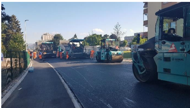
Belageinbau Mühlemattstrasse
