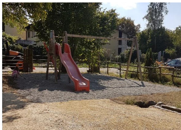
Sanierter Spielplatz am Haselweg
