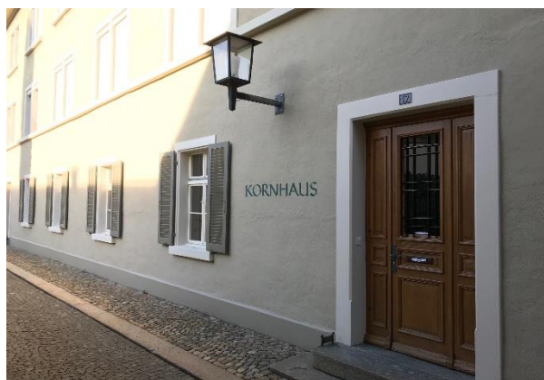
Die sanierte Fassade im Erdgeschoss wertet die Ringmauer-gasse auf
