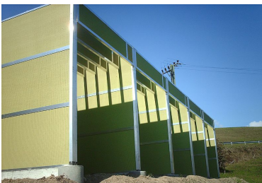
Esempio di adozione di baffles (setti Siang della ditta Süssmann)
