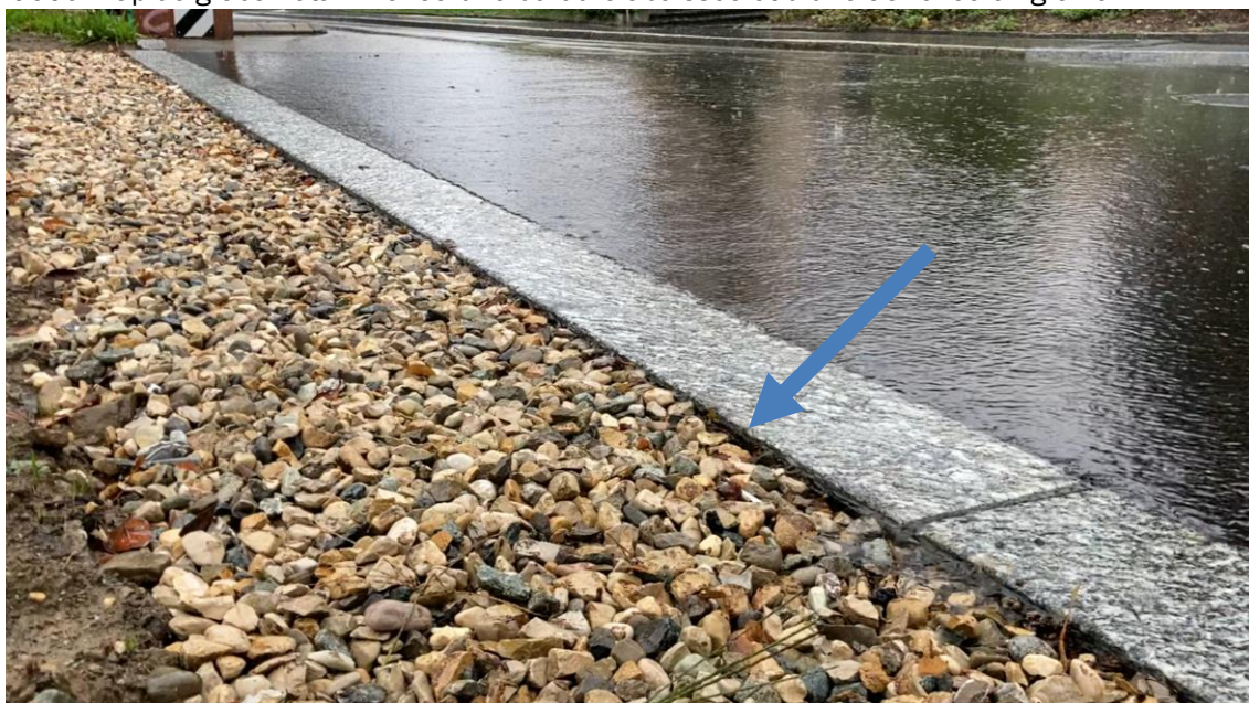
Photo, La bordure abaissée et la tranchée en gravier de la noue à l'avenue de Jolimont.
