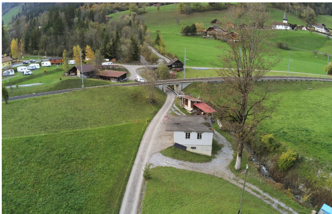
Abbildung 15 Blick flussaufwärts BLS Brücke, Camping und bestehende Zufahrt Mülibüel
