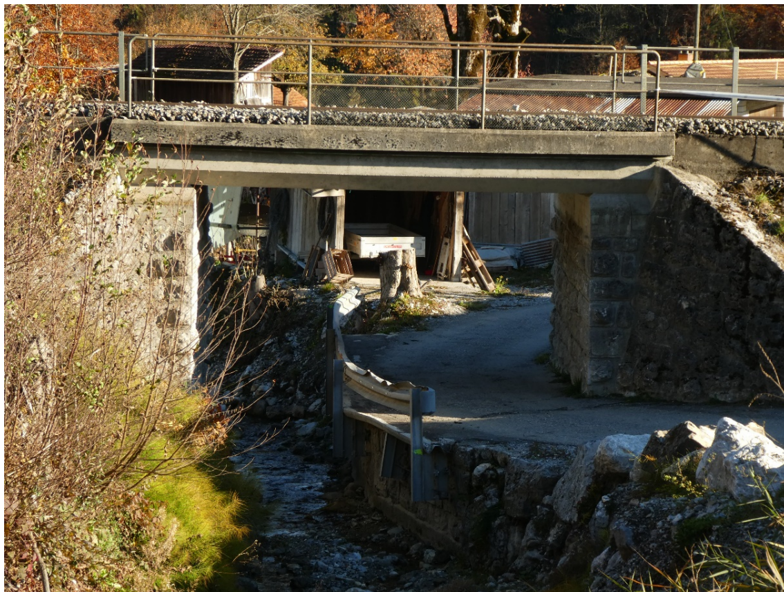
Abbildung 13 BLS-Brücke mit Strassentrasse im Abflussquerschnitt (Blick in Fliessrichtung).
