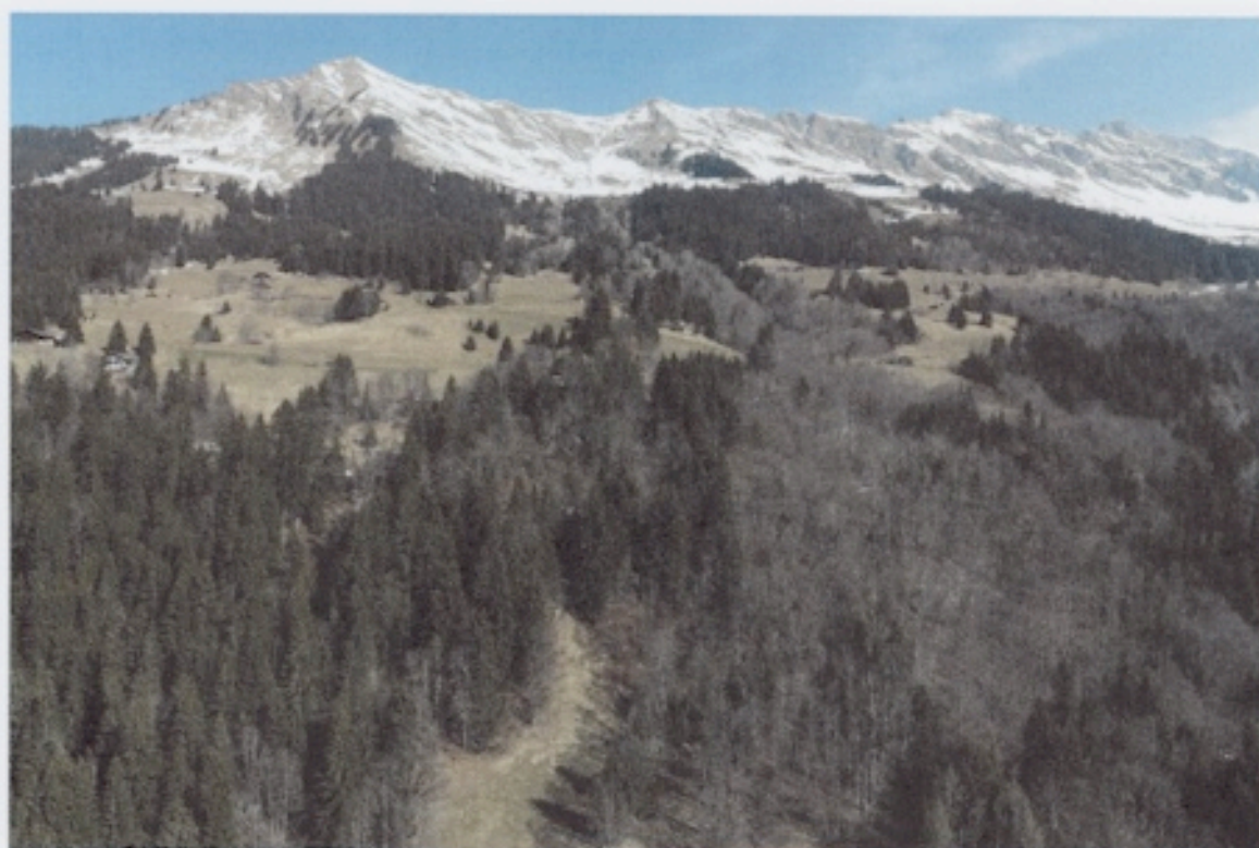
Figure 4 : Vue des zones de décrochements et de la zone de transit de l'avalanche.
