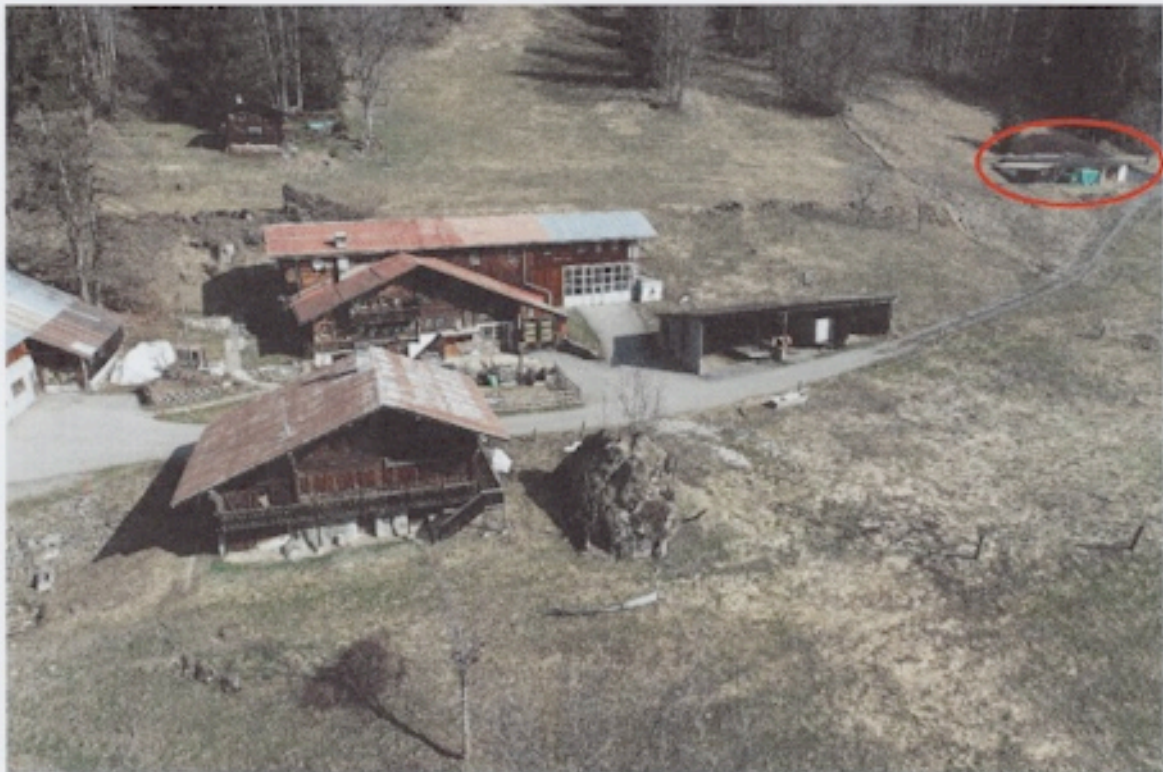
Figure 1 : Au premier plan, le chalet à protéger ainsi que le bloc de rocher protégeant le chalet. Le bâtiment en rouge a été emporté par l'avalanche de 1984.
