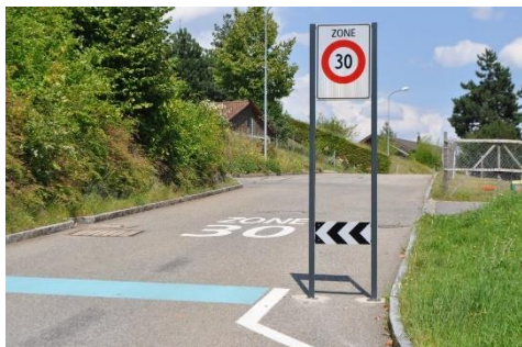
Abb. 9: Referenzbild Torsituation mit Markierung «Zone 30» (Quelle: Signal AG, abgerufen am 11.03.25)
