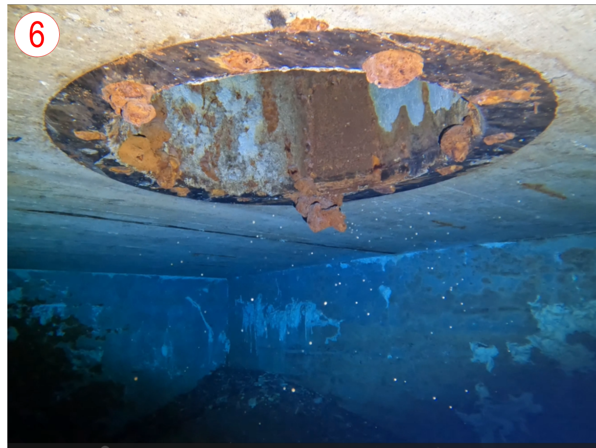
Inspektion Druckkammer Zuleitung Kiesen ROV.mp4 (6min)
