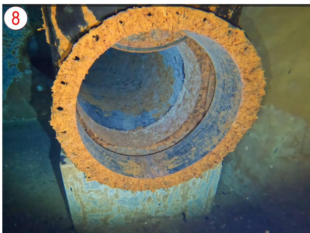
Inspektion Druckkammer Zuleitung Kiesen ROV.mp4 (6 min)
