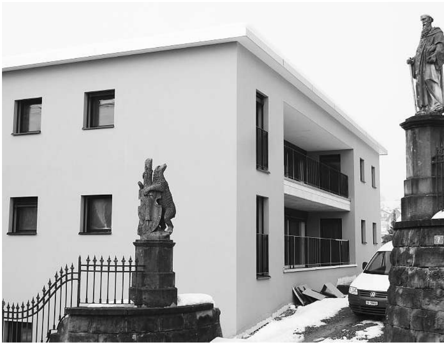
Neues Wohn- und Geschäftshaus an der Rickenstrasse
