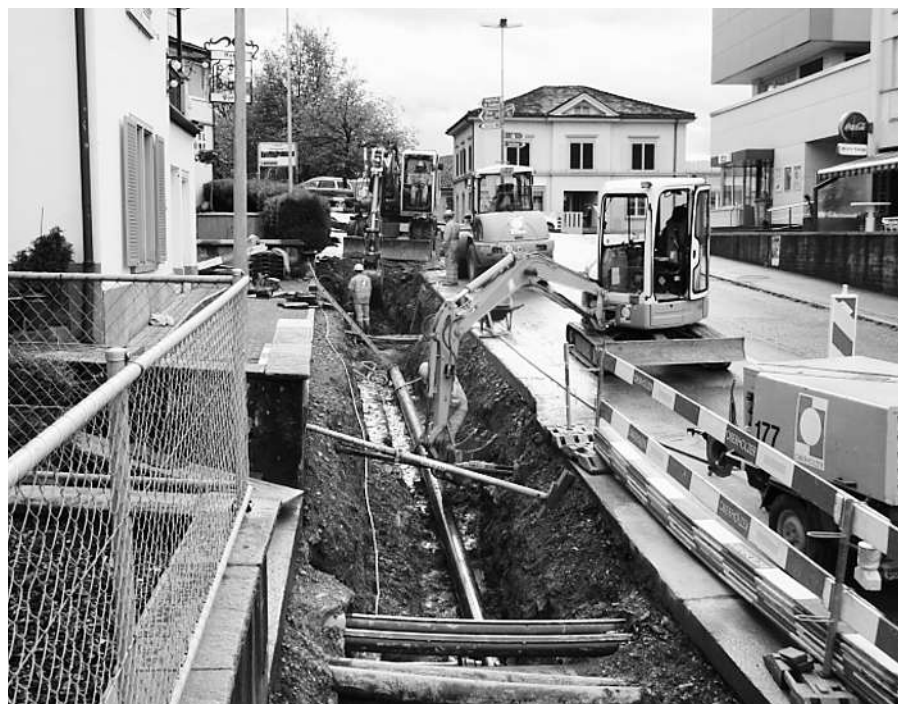
Werkleitungsbau entlang der Zürcherstrasse.
