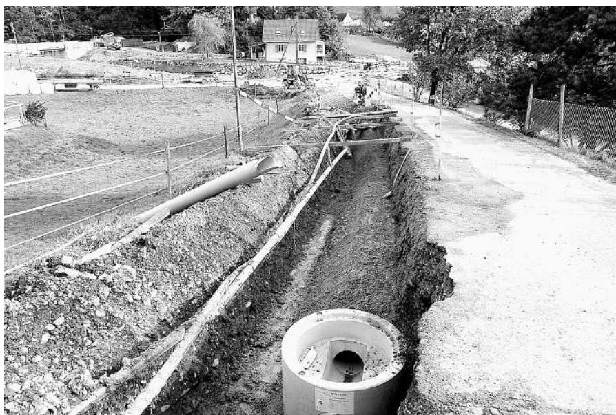
Werkleitungen in der Heubergstrasse wurden erneuert.
