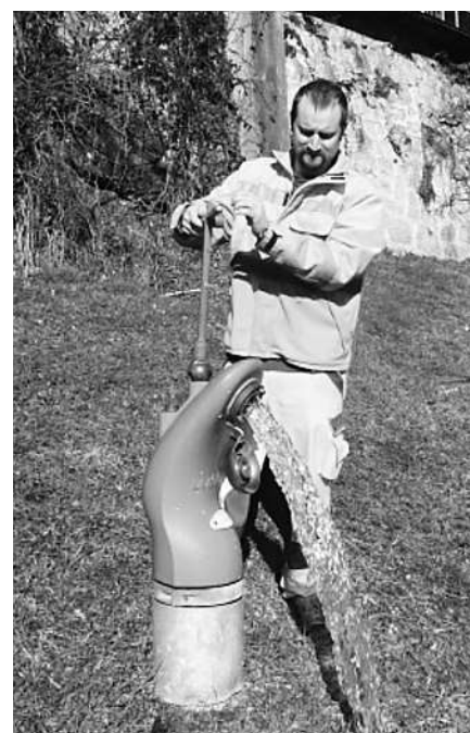
Brunnenmeister Markus Zweifel beim Hydrantenspülen.
