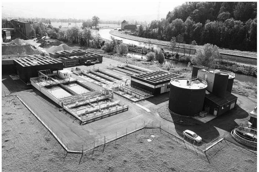
Die sanierte und erweiterte ARA Obersee wurde der Bevölkerung am 20. September 2014 vorgestellt.
