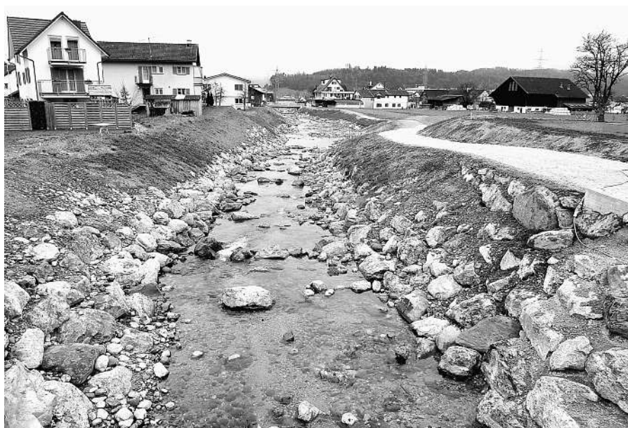
Zusammen mit dem Ausbau des Ernetschwilerbachs konnte eine durchgehende Wegverbindung ab Täli bis Allmeindstrasse geschaffen werden.
