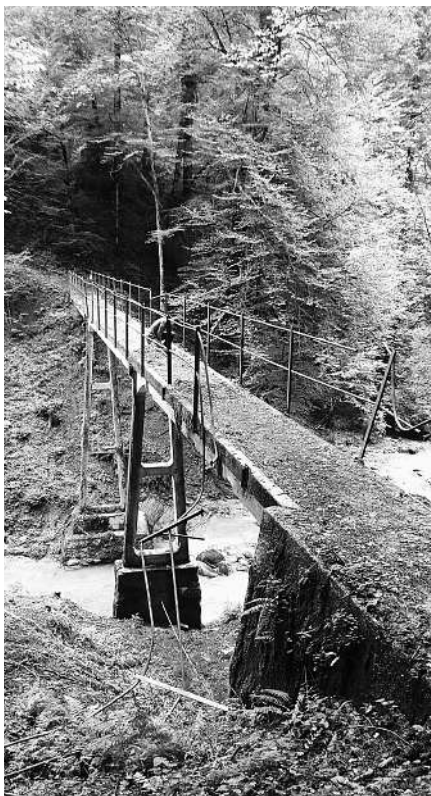
Die Sanierung der Hebeltobelbrücke ist ausgewiesen.
