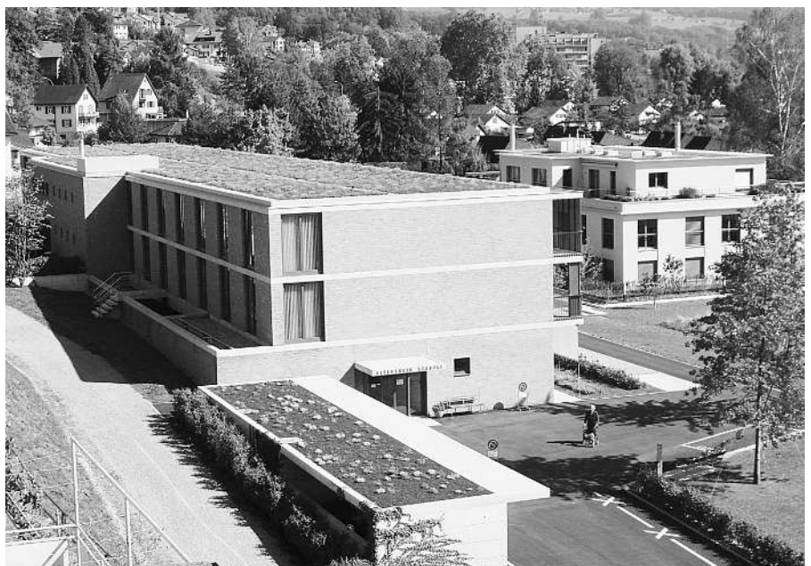
Das Flachdach des Altersheims Städtli eignet sich für Photovoltaik- und thermische Solaranlagen.
