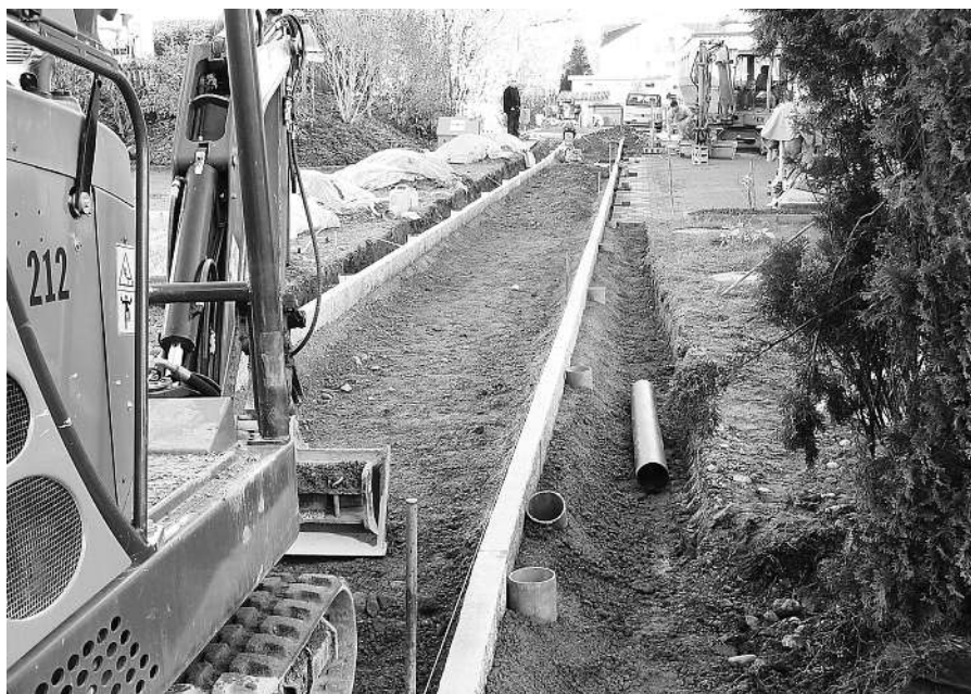
Die quartierinterne Fusswegverbindung zwischen Brauereistrasse Ost und den Schulanlagen Ausserhirschland ist erstellt.
