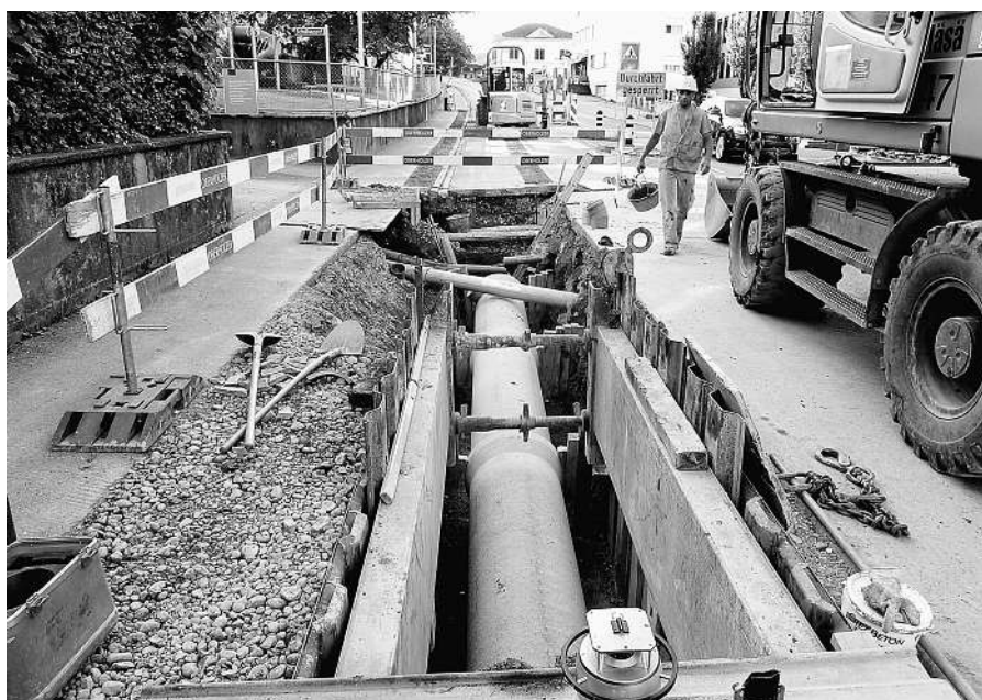
Werkleitungsbau in der Zürcherstrasse
