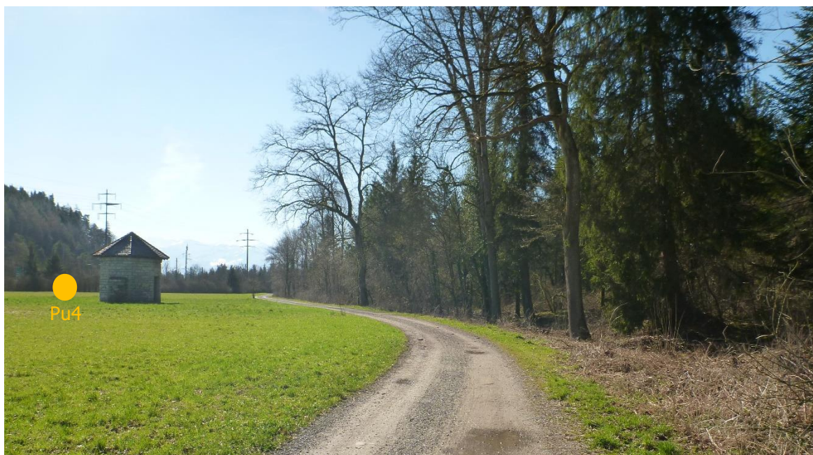
Abbildung 8 Blick Richtung Süden. Das Brunnengebäude sowie der Weg werden zurückgebaut und die Bodenfläche wird rekultiviert. Direkt neben dem Brunnengebäude erfolgte die Bodenansprache Pu4.
