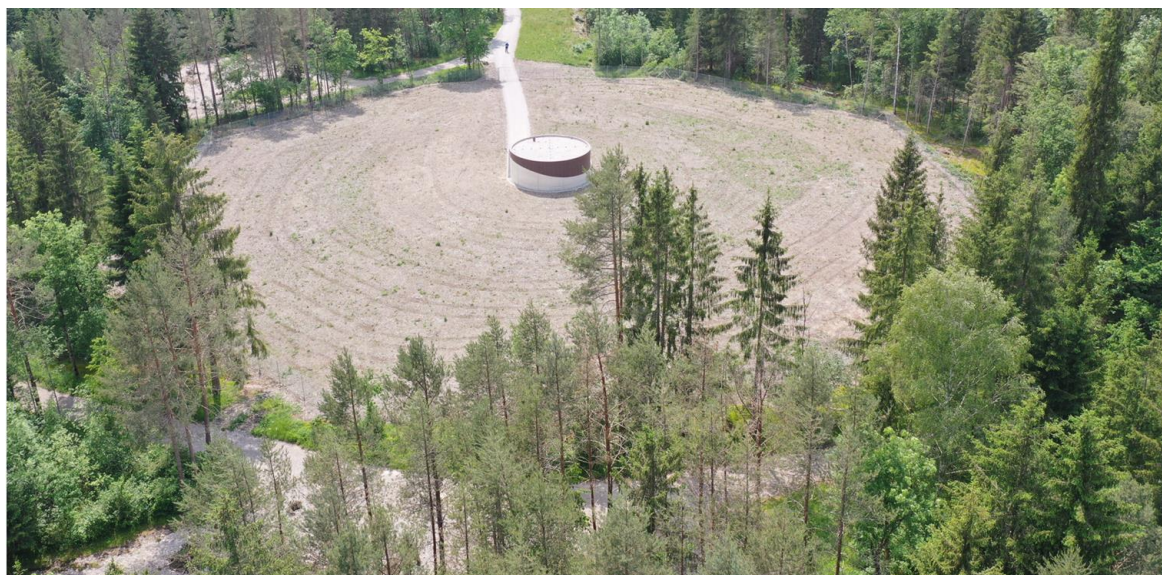
Abbildung 1: Drohnenaufnahme der im Frühling 2023 fertiggestellten Grundwasserfassung "Oberi Au".
