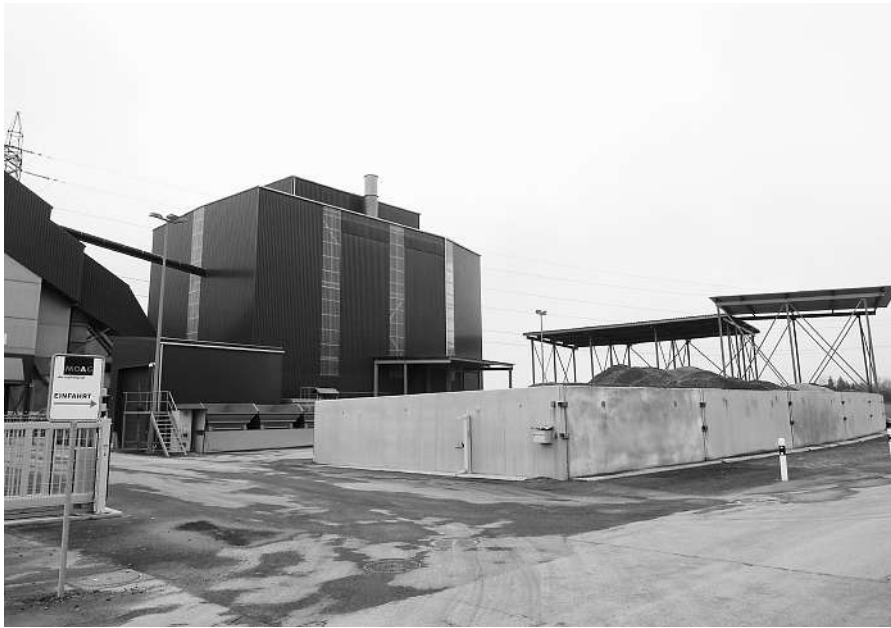
Die neue und erweiterte Asphaltmischanlage in der Grynau/Büelerriet.
