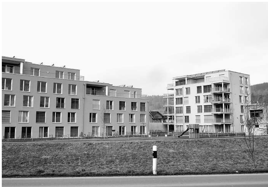
Die Überbauung in der Escherwiese.
