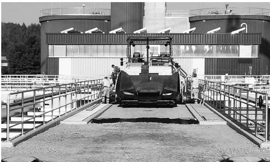
Die sanierte und erweiterte ARA Obersee wird im September 2014 der Bevölkerung gezeigt.
