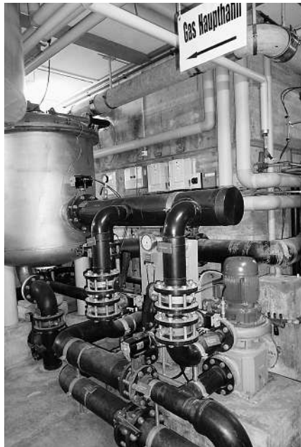
Die Badewasseraufbereitung im Schwimmbad Herrenacker wurde erneuert.
