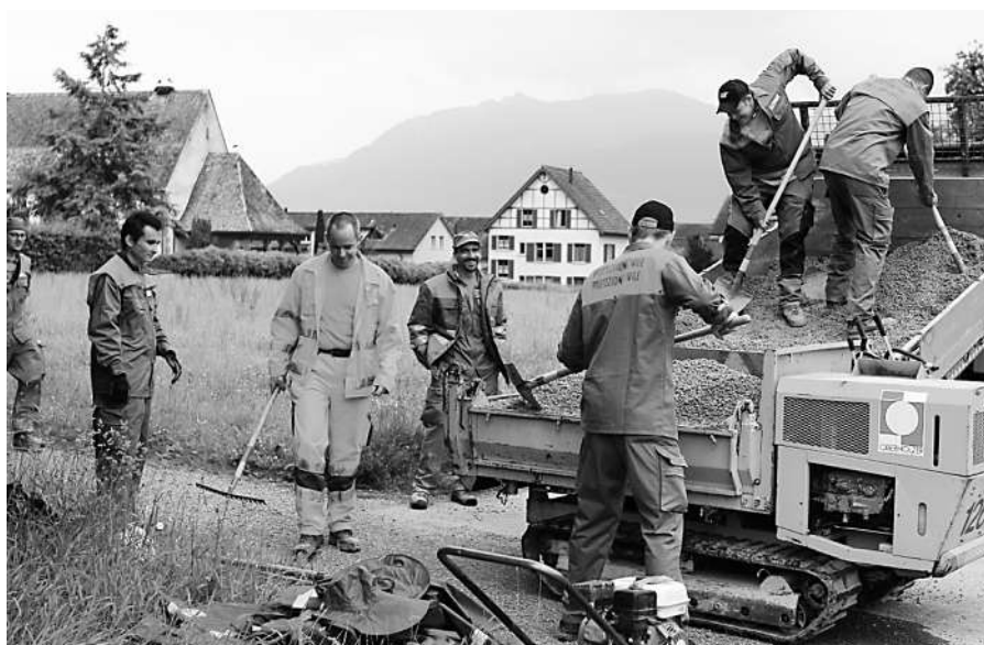
Auch der Storchenweg wurde während des WKs von der Zivilschutzorganisation Obersee-Ricken saniert.
