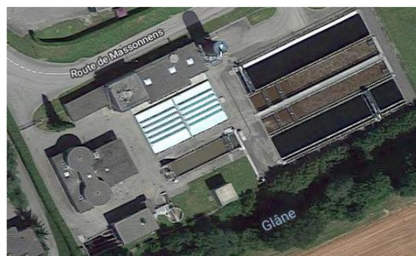
Avec la station d'épuration de Romont
