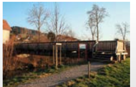
Zwei riesige Douglasien aus dem Rosset-Wald ob Sirnach tragen die imposante Brücke.
