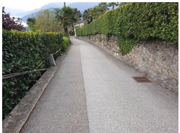
Risanamento corona muro esistente e posa barriera di sicurezza
