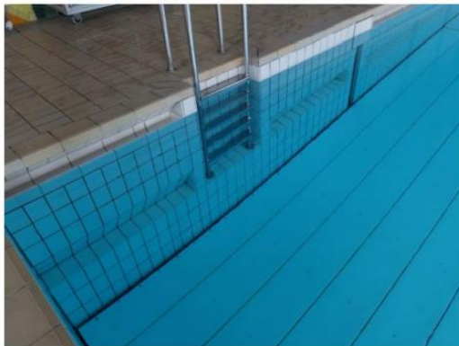
Beckenkörper mit Überlaufrinne, Stehstufe, Nischenleiter und Hubboden
