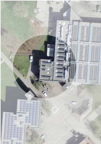
Die ehemaligen Hauswartwohnungen werden zu Büroräumlichkeiten umgebaut.
