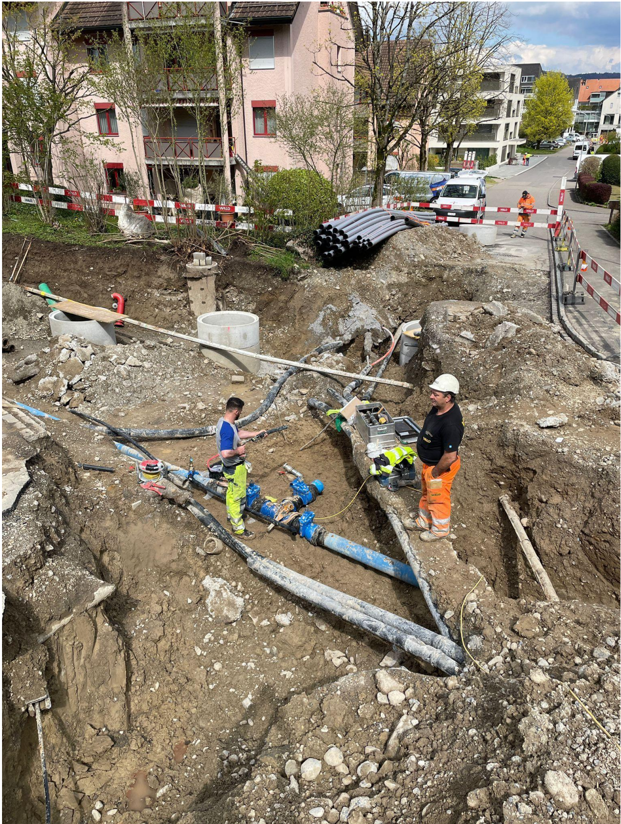
Werkleitungssanierung an der Lättenstrasse
