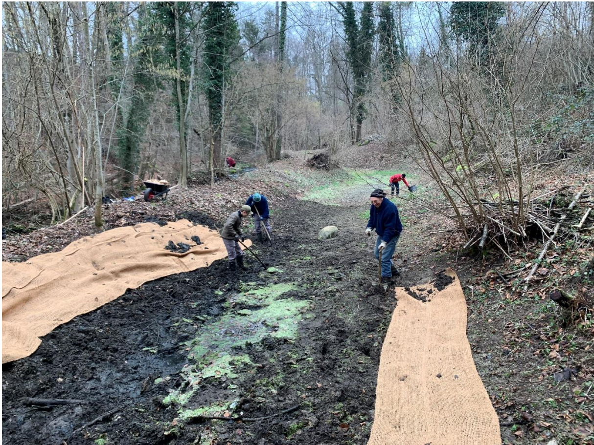
Sanierung Weiher im "Träntsch"
