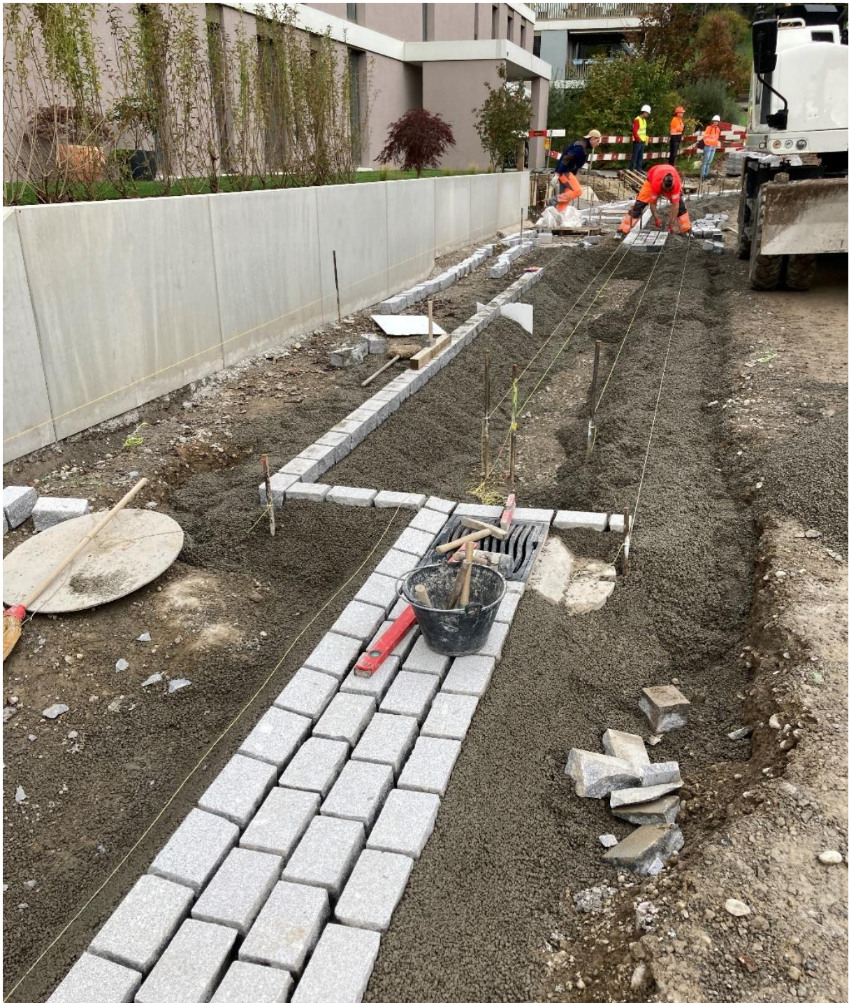
Pflasterung Entwässerungsrinne an der Haselstrasse mit breitem Trottoir und Baumgrube
