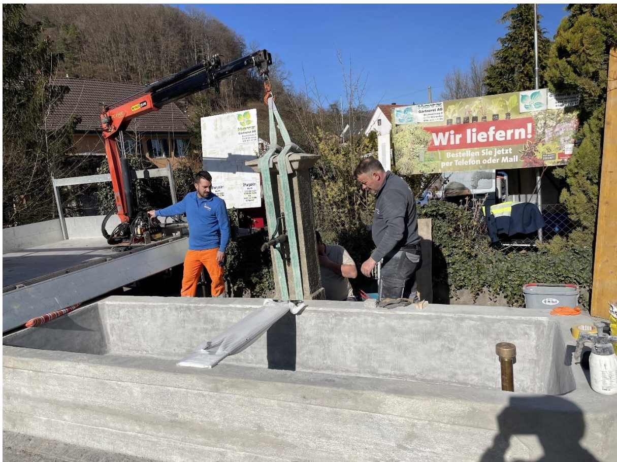
Sanierung des Brunnens am Brunnenweg (vor der Gärtnerei Hotz)
