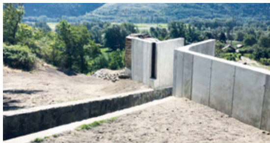
v. l. n. r. Massnahmen im Bereich der Kantonsstrasse: Abschlussmauer mit Überlastsektor und vertikale Rohre – Massnahmen oberhalb des Chummudeerfjis: Ausleitbauwerk nach links, über Korridor in Talebene. Es fehlen auf dem Bild noch die Dammbalken zwischen den beiden Flügelmauern.
