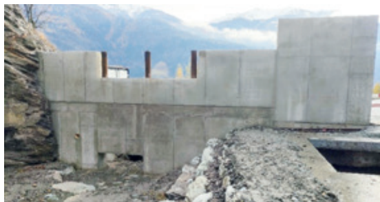
v. l. n. r. Massnahmen im Bereich der Kantonsstrasse: Abschlussmauer mit Überlastsektor und vertikale Rohre – Massnahmen oberhalb des Chummudeerfjis: Ausleitbauwerk nach links, über Korridor in Talebene. Es fehlen auf dem Bild noch die Dammbalken zwischen den beiden Flügelmauern.
