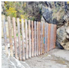
v. l. n. r. Massnahmen im Bereich der Kantonsstrasse: Abschlussmauer mit Überlastsektor und vertikale Rohre – Massnahmen oberhalb des Chummudeerfjis: Ausleitbauwerk nach links, über Korridor in Talebene. Es fehlen auf dem Bild noch die Dammbalken zwischen den beiden Flügelmauern.
