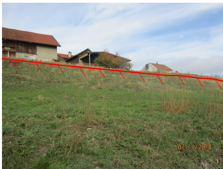
Figure 2 : Parcelles en zone à bâtir avec habitations préexistantes en amont de la zone en glissement.
