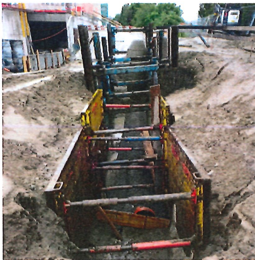
Photo 2 - Changement de méthode de « coffrage » à la suite de fouille plus profonde
