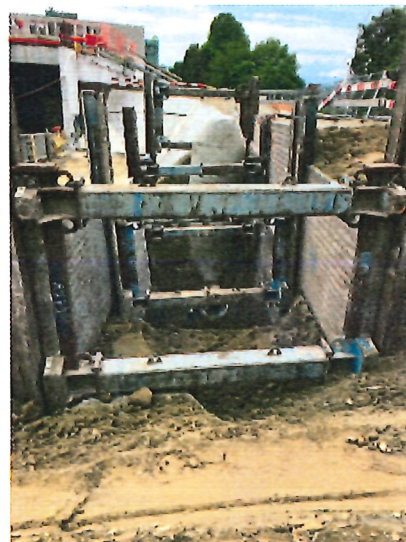
Photo 2 - Changement de méthode de « coffrage » à la suite de fouille plus profonde
