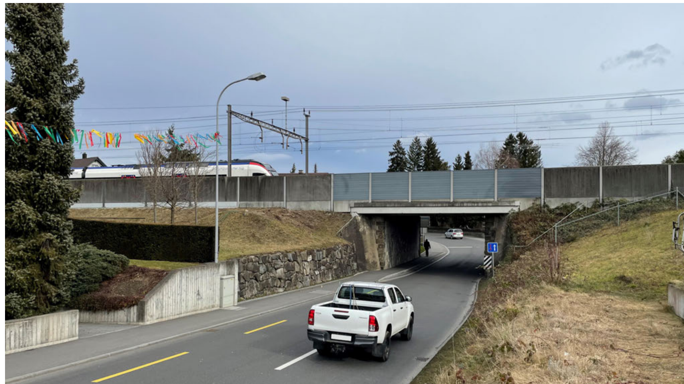
Die Bahnunterführung an der Zürcherstrasse heute.
