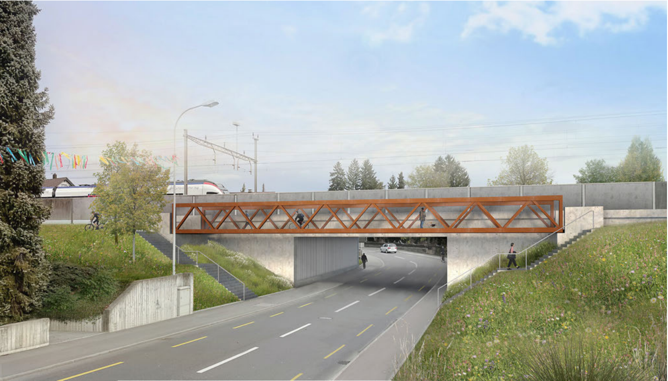
Die Unterführung wird mit einer neuen Breite von 13.20 m verkehrstechnisch verbessert und mit einer Rad- und Fusswegbrücke ergänzt.
