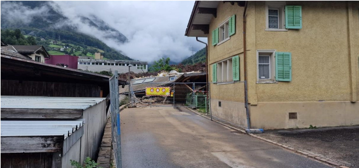
Abb. 1 - zeigt die Absperrung nach dem Ereignis am 29. August 2023
