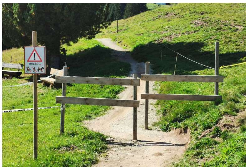
Abbildung 4: Holzschranken zur Temporeduktion.
