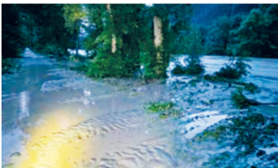
Das Ufer des Rottens zwischen Raron und Niedergesteln anlässlich des Unwetters von Ende Juni.
