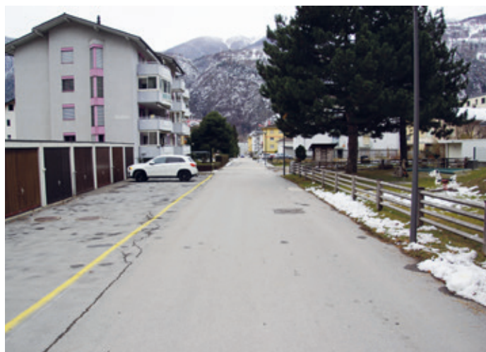
Zweite Etappe der Sanierungsarbeiten Bietschgärtenstrasse ab Anfang 2021
