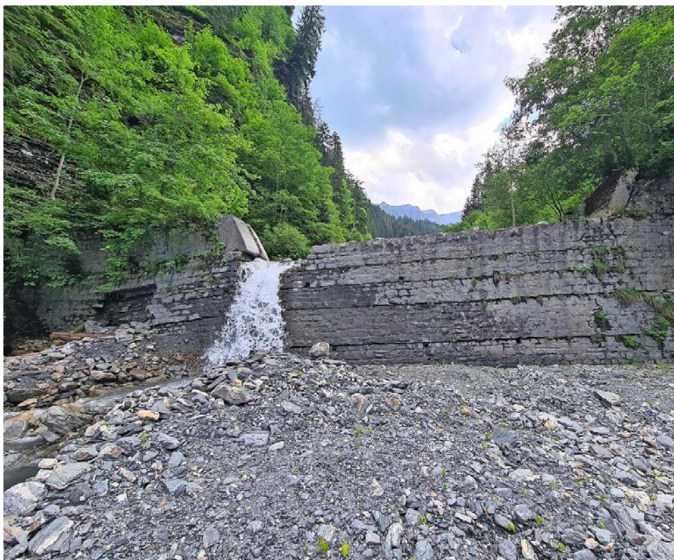
Heutiger Zustand der Nollaverbauung «Sperre 8»: Die Mauer ist eingebrochen und stark erodiert. Sie wird durch eine 15 Meter hohe Verbauung verstärkt. Neu kommt ein Tosbecken hinzu, das die Fließgeschwindigkeit bremst.
