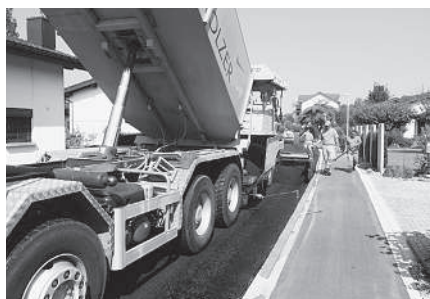
Deckbelagsarbeiten Mühlastrasse
