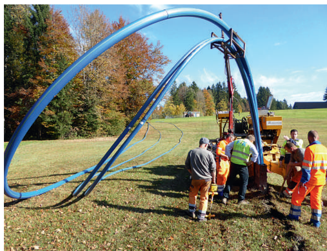
Einpflügen der neuen Leitungen auf dem Ricken
