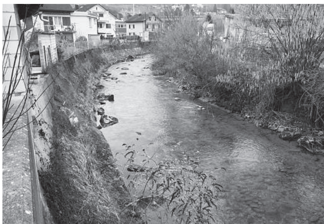
Harte Uferverbauungen beim Aabach
