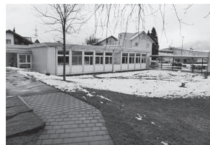
Sanierungsbedürftiges Schulhaus Ausserhirschland
