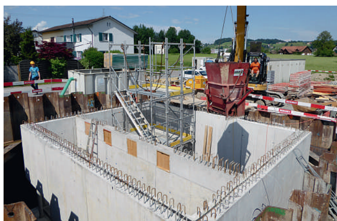
Rohbauarbeiten an der Meteorwasser-Pumpstation
