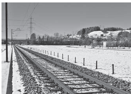
Grundwasserfassung Burgerriet mit Blick auf Eisenbahngleis
