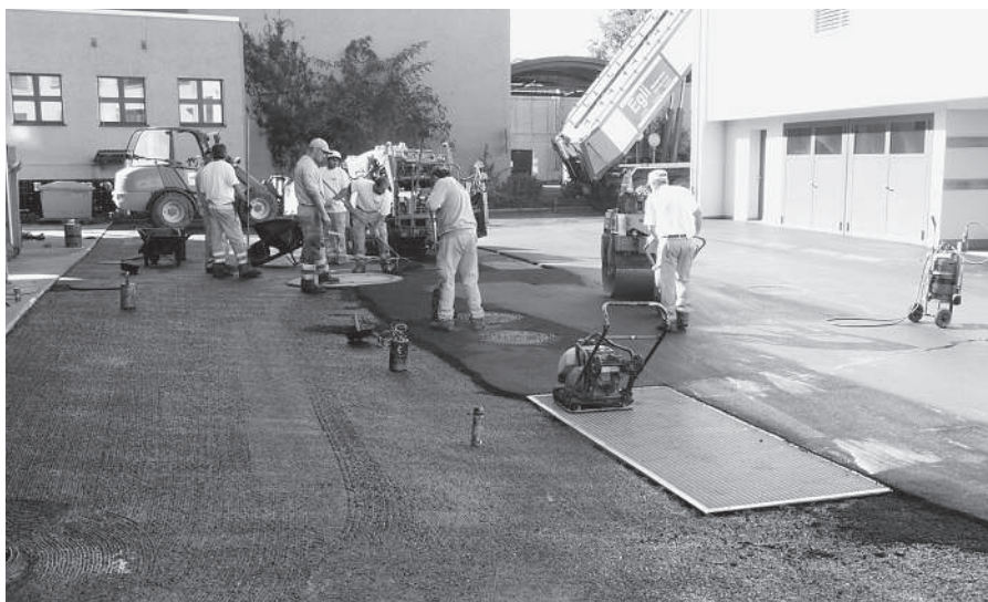
Ersatz des Deckbelages beim Werkhof
