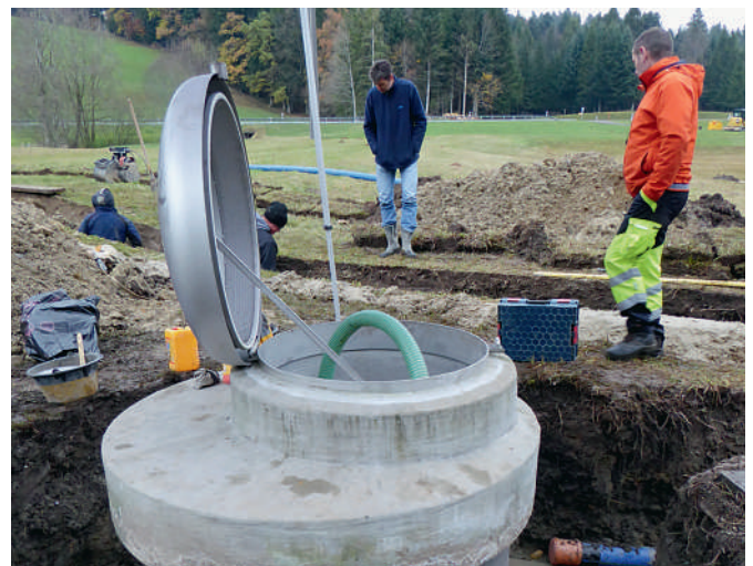
Sanierung des bestehenden Quellschachtes auf dem Ricken
