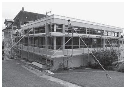
3-fach-Verglasung beim Schulhaus Bifang
