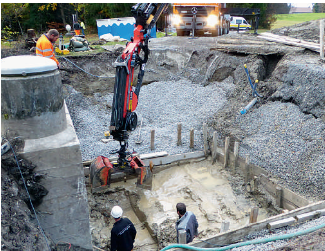
Aushub für den neuen Sammelschacht auf dem Ricken
