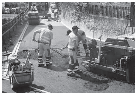
Belagsarbeiten beim Haselgässchen
