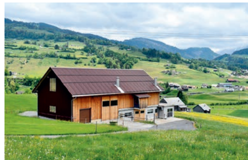
Rindviehscheune mit Anbindestall, deckenlastigem Futter- und Strohlager, Milchraum und Remise / Tobel-Bühl, Nesslau.
