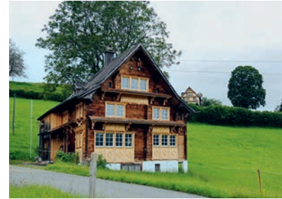
Sorgfältig saniertes Steilfirsthaus / Blomberg, Ebnet-Kappel.
