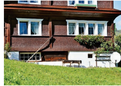
Die Wandöffnung des Sockelgeschosses ist möglichst breit, damit zum Weben genügend Licht in den Keller gelangt / Rüteli, Krummenau.
