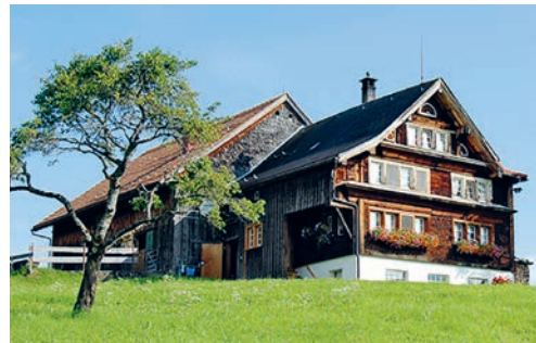
Wohnhaus mit mittlerer Dachneigung und rückseitigem Scheunenanbau / Buechholz-Bühl, Nesslau.
