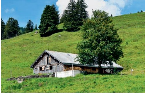
Alpgebäude mit Stallraum, Futter- und Strohlager; hangseitig mit Sennerei, Käsekeller und Schlafkammer / Rueboden, Stein.
