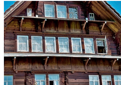
Die grosse Firstkammer liegt im zweiten Obergeschoss und überspannt die ganze Hausbreite / Ganten, Ebnet Kappel.
