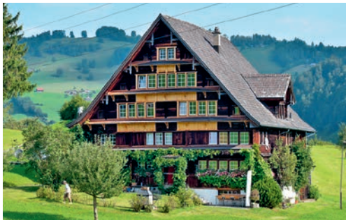
Stättliches Wohnhaus mit Steilfirst, giebelseitigem Hauseingang und zwei Wohneinheiten / Niederhufen-Bühl, Nesslau.
