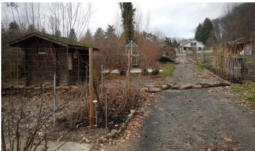
Débordement des eaux du ruisseau de Broye en 2014 sur les parcelles et les cheminements des jardins familiaux
