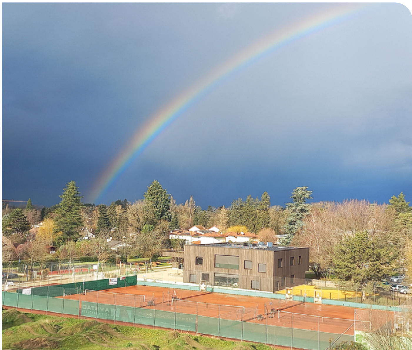
Arc-en-ciel sur Troinex et ses nouvelles infrastructures.
