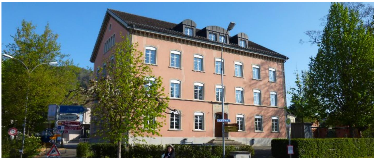
Abb. 1: Schulhaus Schanz, Strassenansicht
