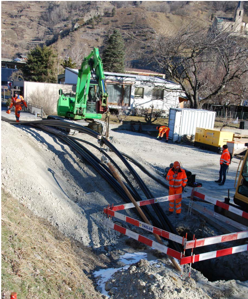
Baustelle: gesteuerte Bohrung unter dem Rotten
