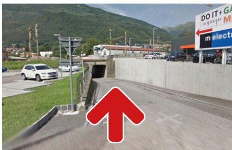
SOTTOPASSAGGIO VIA INDUSTRIA
