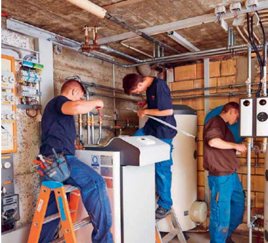
Wärmepumpeninstallateure «in Action»
