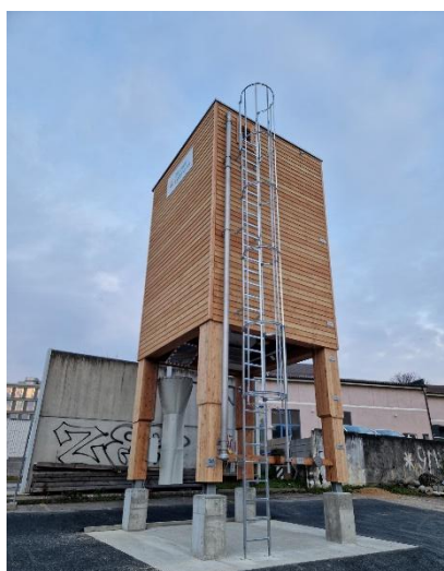
Silo à sel © service Exploitation & Gérance
