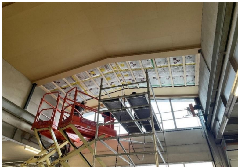
Réfection du plafond du local dépôt véhicules de la Voirie © service Domaines et Bâtiments
