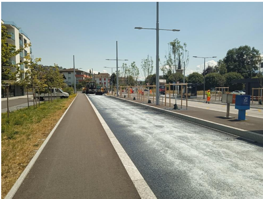
Pose de la couche de roulement sur la Route de Cossonay @ service Infrastructure et Espaces publics
