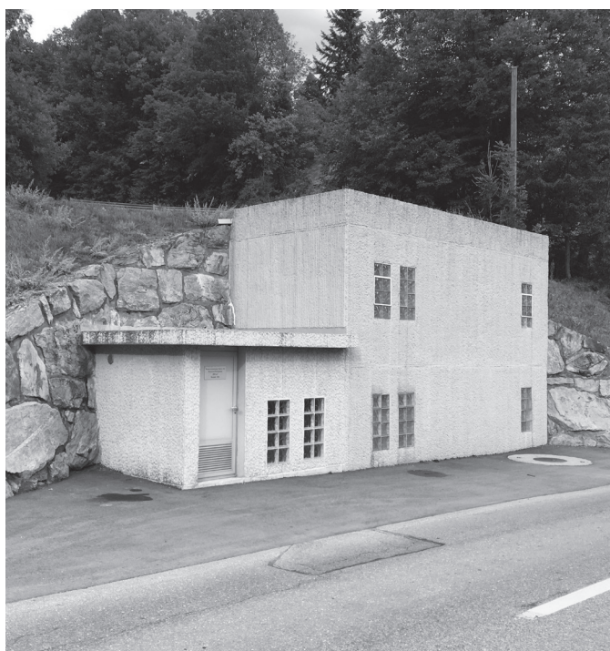
Aussenansicht des Reservoirs «Chilchmatta»
