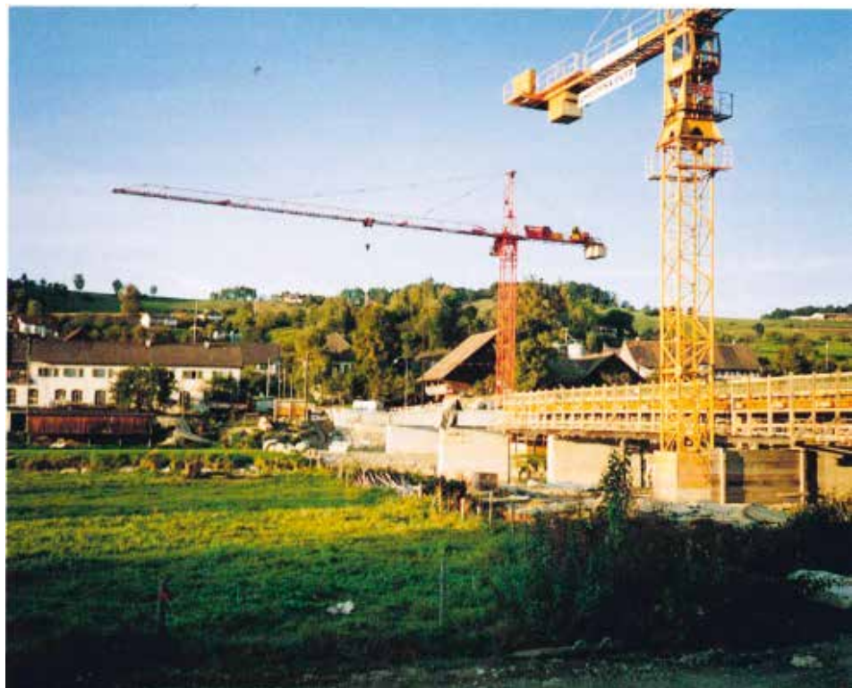
Der ständig steigende Verkehr und die Ortsdurchfahrt, die anstelle einer Umfahrung ausgeführt worden ist, bedingt den Bau einer neuen Brücke.
