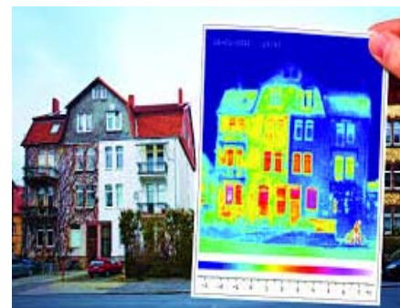
Beispiel Wärmebildaufnahme (Rechte Hausseite ist wärmedämmend)
