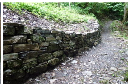
Sanierte Trockenmauer am alten Landweg in Bauen
