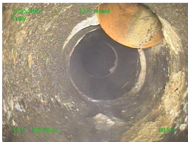
Embranchement non étanche et concrétions calcaires
