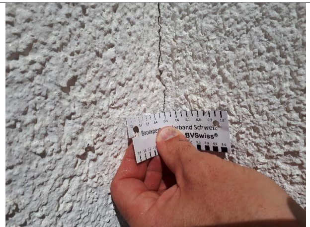
Riss ca. 0.5mm, nach oben zunehmend!
