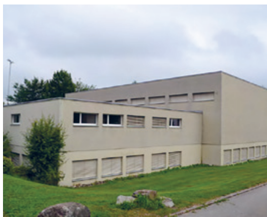
Ansicht Fassade Ost
