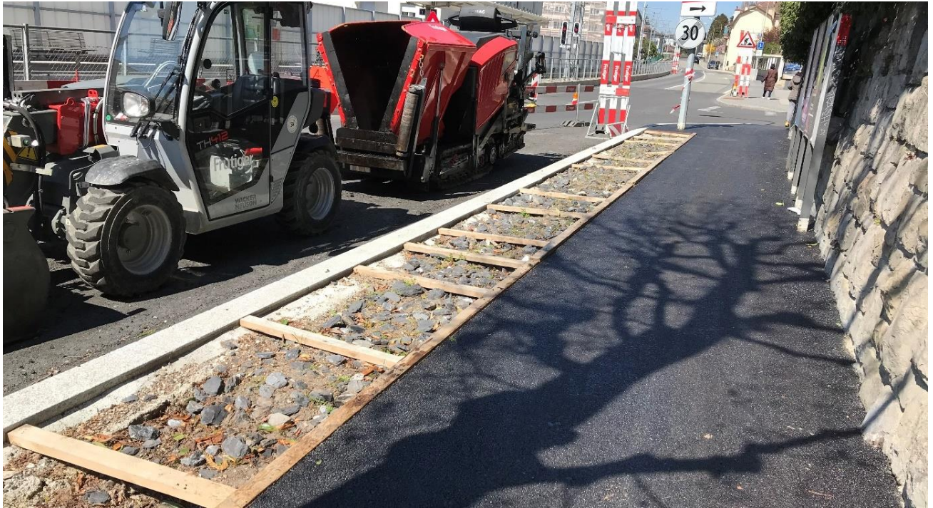
Figure 5 Photo de la fosse d'arbre en terre-pierre, qui est également présente sous le trottoir, la pente de ce dernier amène les eaux de pluie vers la fosse.
