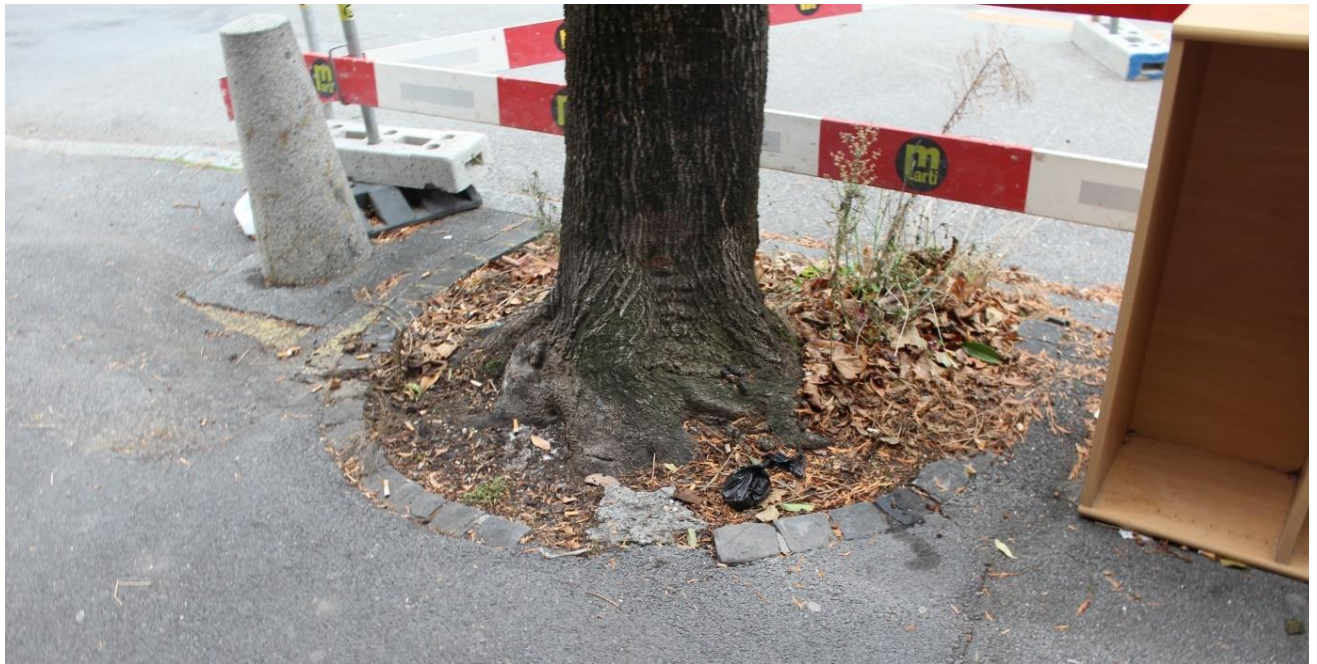
Figure 2 Situation de l'arbre existant sauvegardé avant travaux (le seul qui était encore « sauvable », les 2 autres étaient dépérissant notamment à cause du manque de sol et à l'imperméabilisation), en plus d'être impactés par le projet de passage inférieur.
