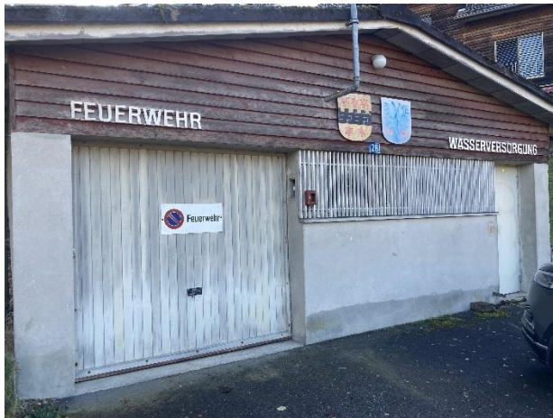
Rechts im Gebäude ist das Quellwasserpumpwerks
