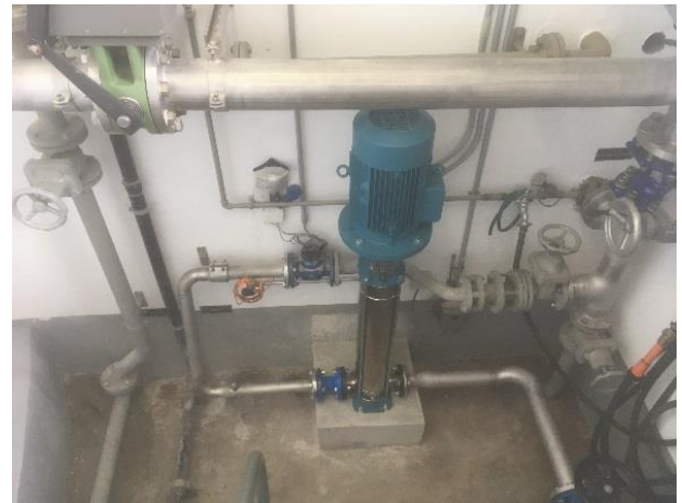
Best. Stufenpumpe im Reservoir Oberi Rüti
