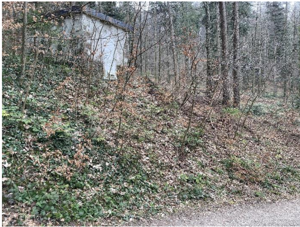
Eingangsgebäude vom Flurweg aus
