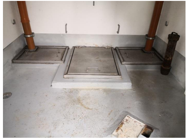
Zugangsgebäude mit Kammereinstiegen, Zulaufbehälter und Belüftungsleitungen
