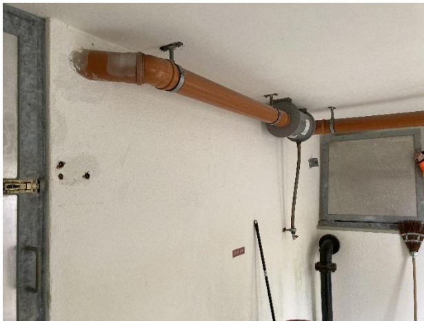
Ehemaliger Zulaufbehälter und Luftfilter
