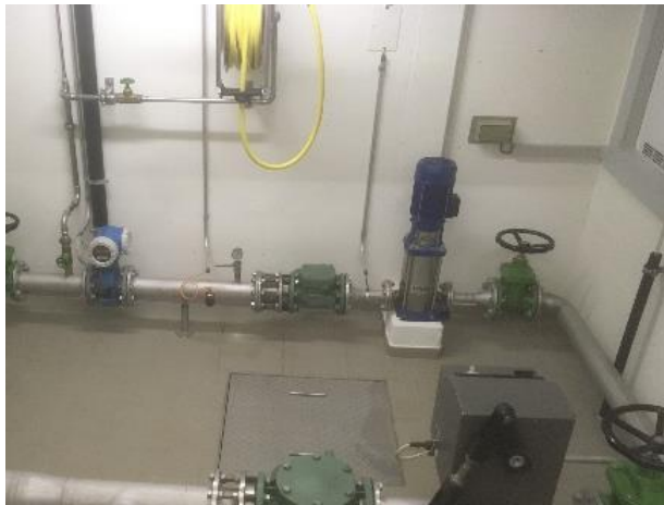
Best. Stufenpumpe im Reservoir Zell
