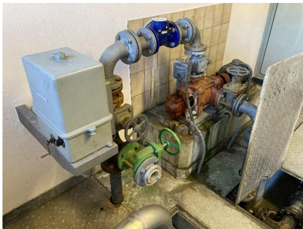
Bestehende Sulzer-Quellwasserpumpe (1959)
