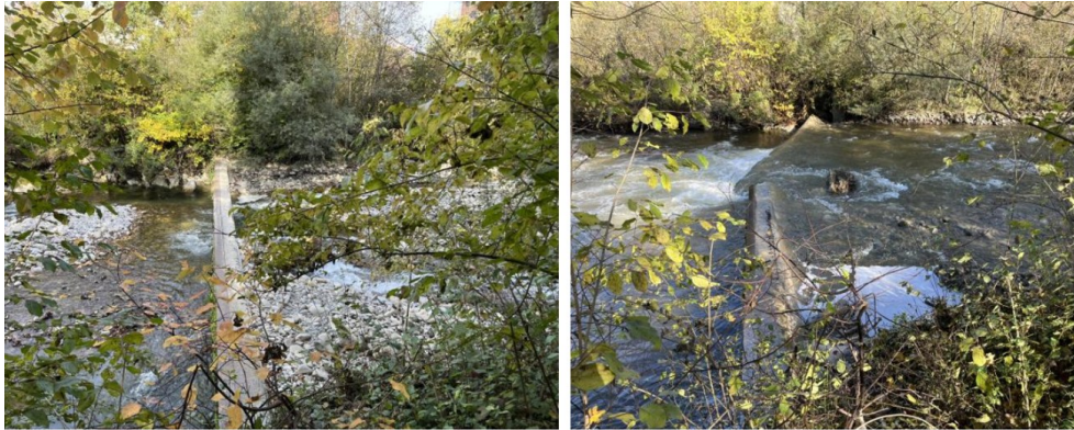
Seuil stabilisateur au km 2.15 : le 19.10.2025 (à gauche) et le 28.10.2025 (à droite)
