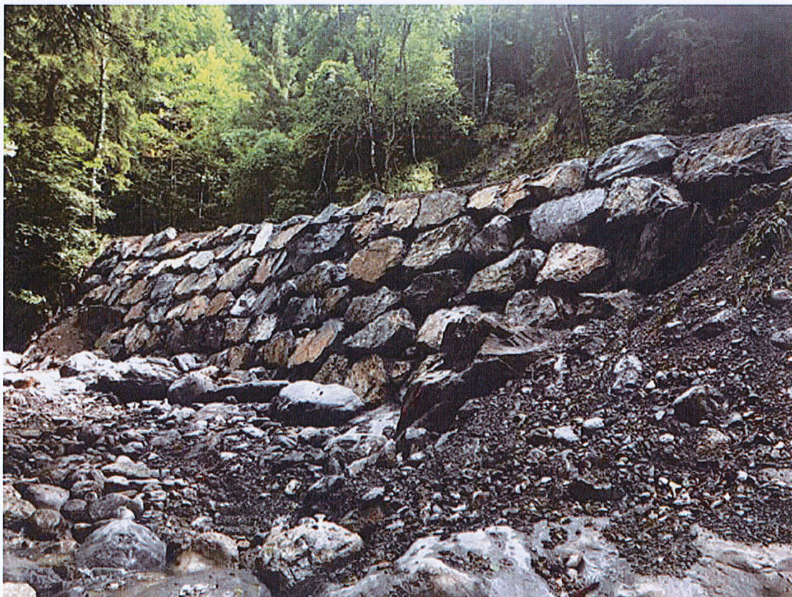
Mesure 3 : protection de berge terminée
