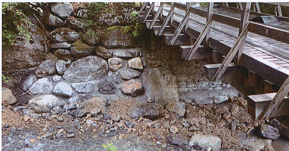
Passerelle amont STEP : reprise en sous œuvre de la berge et de la culée RG
