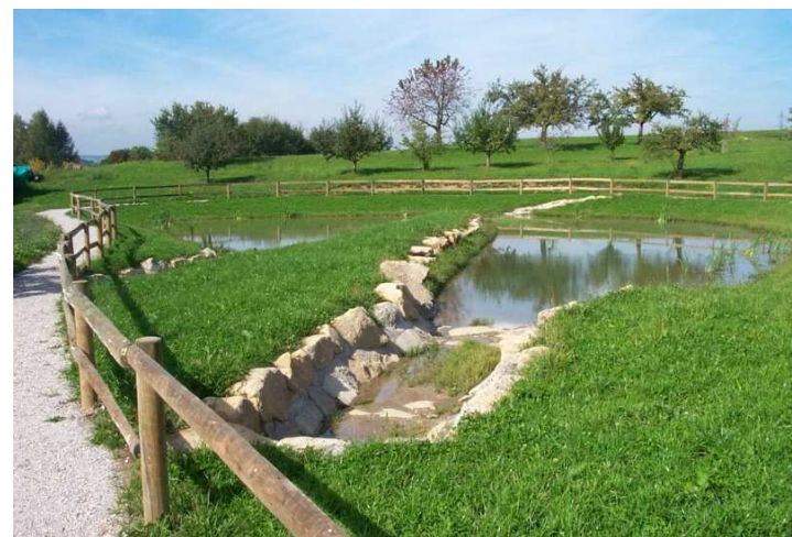
Assainissement par bassin de rétention
