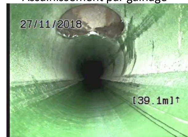
Assainissement par gainage
