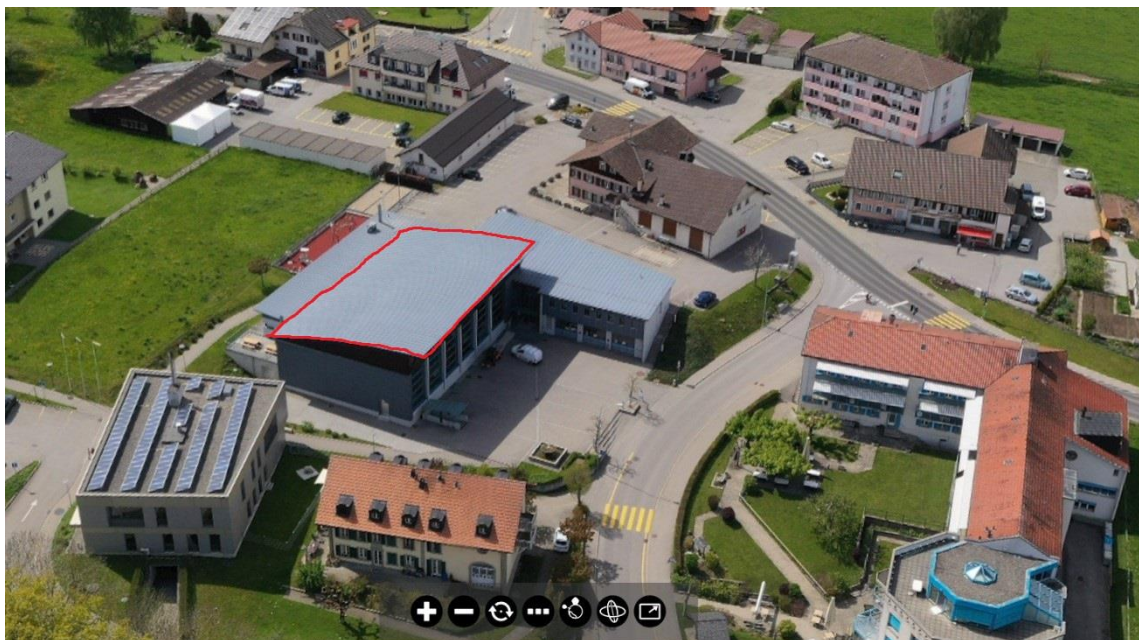
Halle de gym avec, en rouge, la partie à réfectionner
